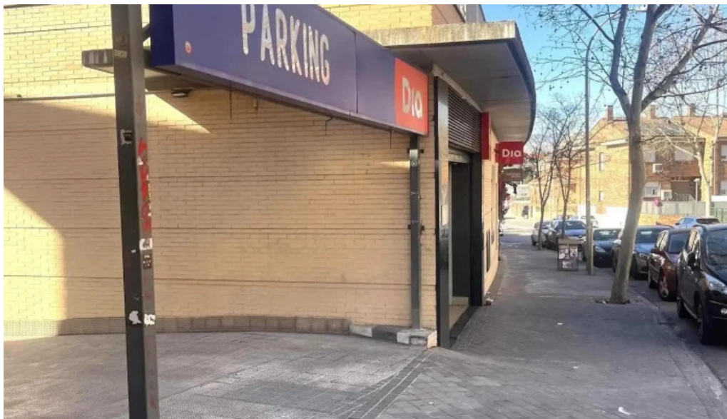
Supermercados dia estacionamiento
