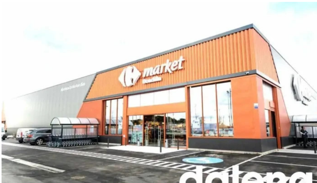
Carrefour market estacionamiento
